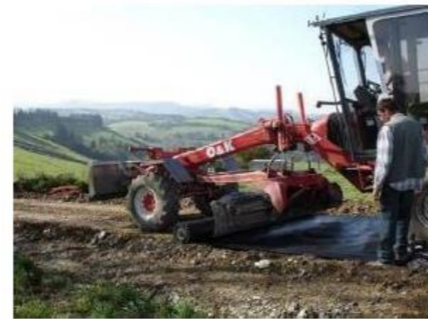
Pose du géotextile
