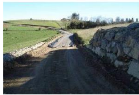
Mise en place du gravier
