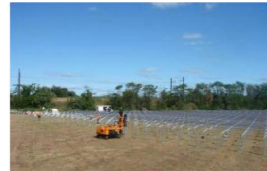
Battage des pieux
