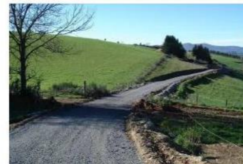
Mise en place du gravier
