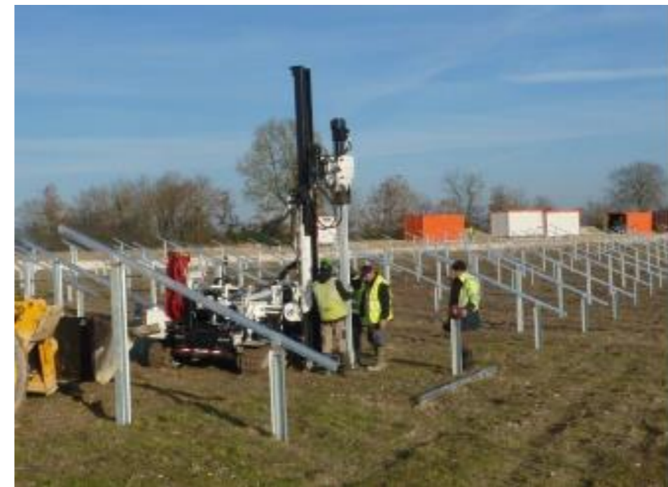
Figure II-11 : Mise en place des supports de panneaux – source : VALECO
