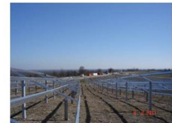
Fixation des rails de support
