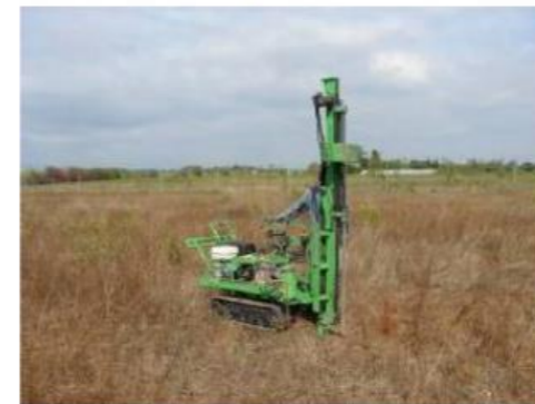
Sondage au pénétromètre
